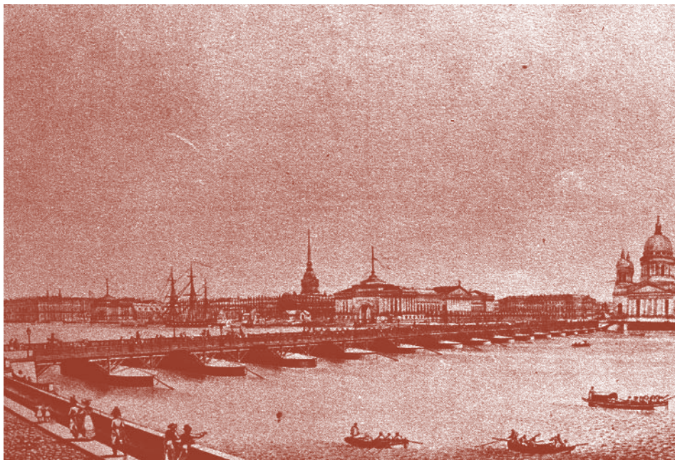
Puente San Isaac (San Petersburgo) (32)
